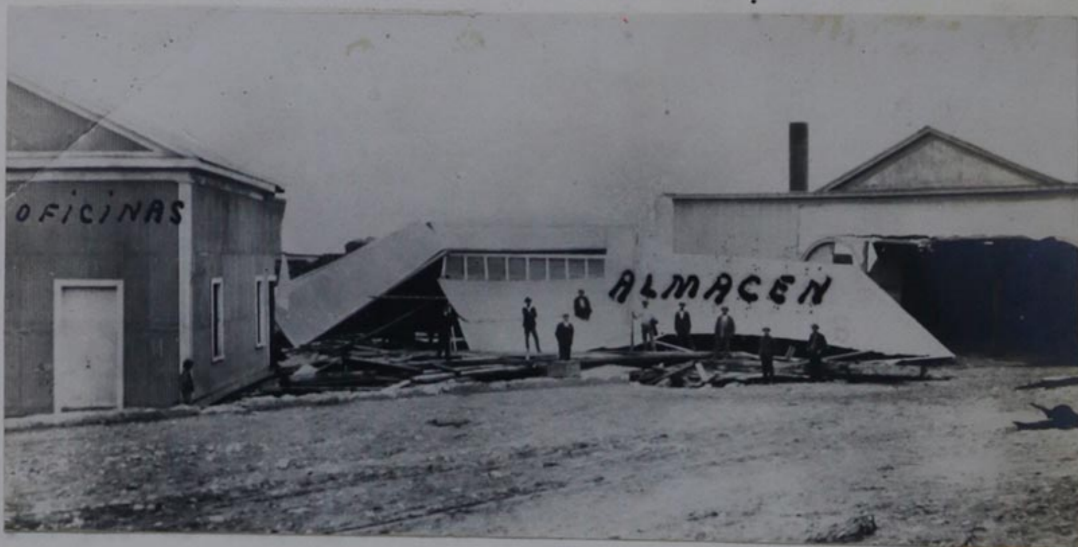
Estado en que ha quedado La Aduana de Caldera.
