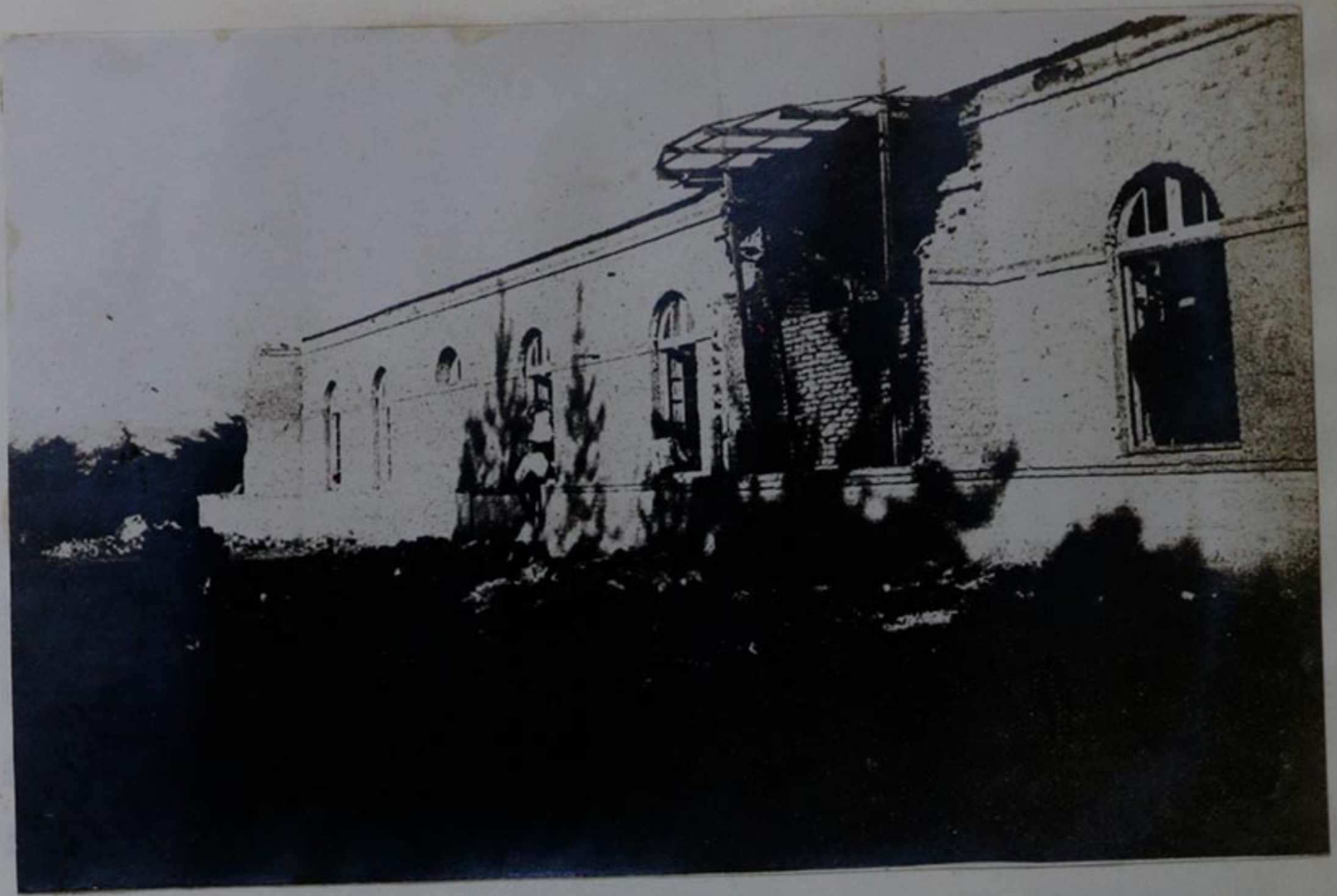
Cuartel del Rjto. "Arica" despues del terremoto.
